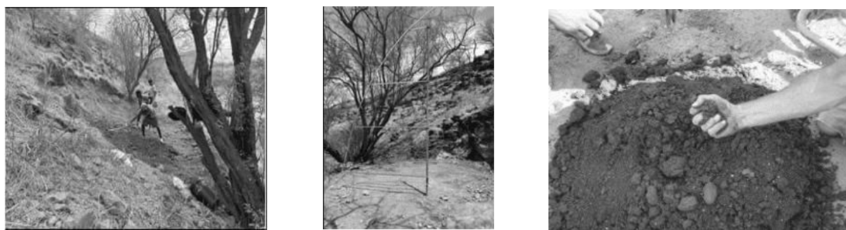
Figura 7: Desbravamento, limpeza, terraplanagem, marcação ao solo e teste rápido.
