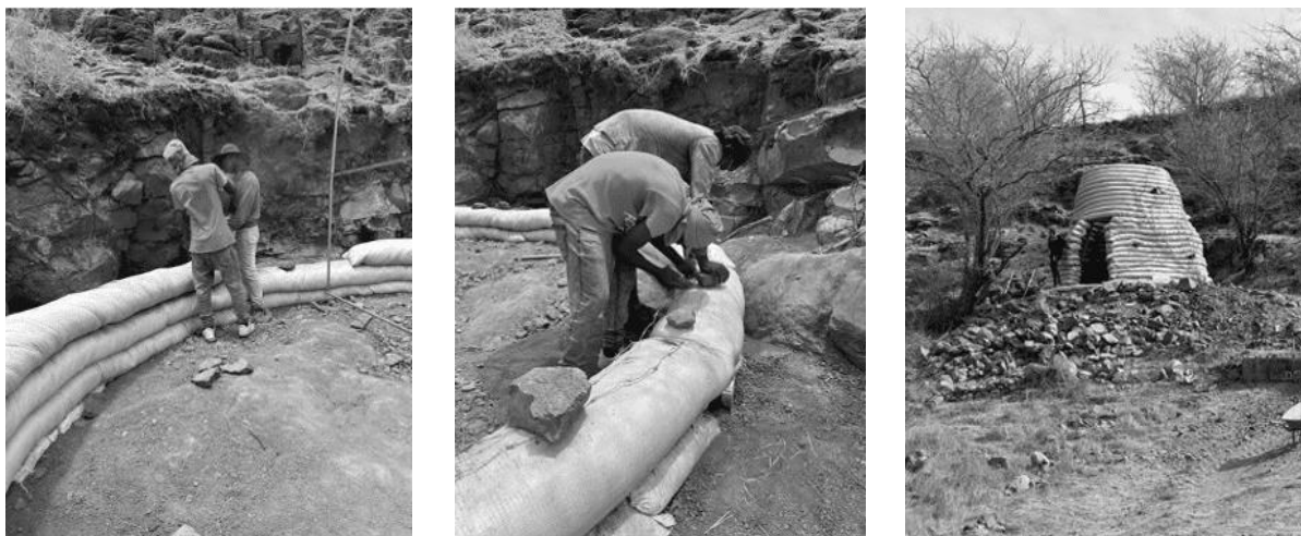
Figura 2: Construção do domo.
